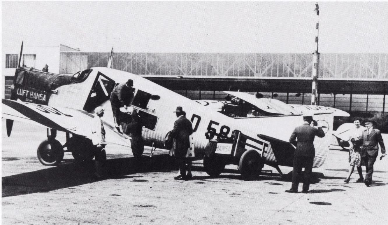
**1000** Junkers F 13, erstes modernes Ganzmetall-Verkehrsflugzeug der Welt. Von 1919–1932 wurden 322 Maschinen gebaut, von denen ca. 55 bei der Deutschen Lufthansa im Dienst waren. 1939 musterte die Lufthansa die letzte F 13 aus. 2 Mann Besatzung, 4 Passagiere.
